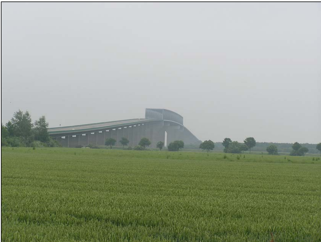
Photo 2: Hochbrücke der Bundesstraße B 5 über den Nord-Ostsee-Kanal
