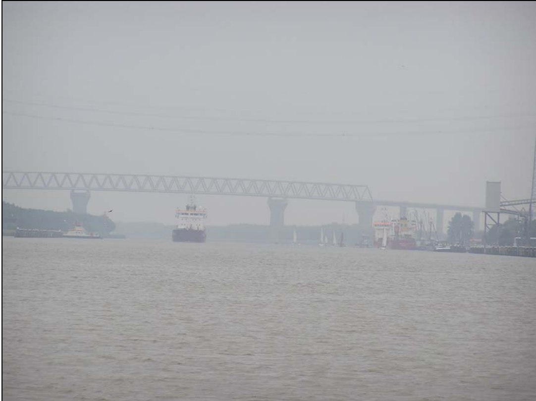
Photo 5: Blick von der Fähre auf die Hochbrücke der Bundesstraße B 5
