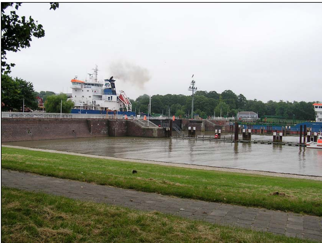
Photo 6: Kanalschleuse in Betrieb
