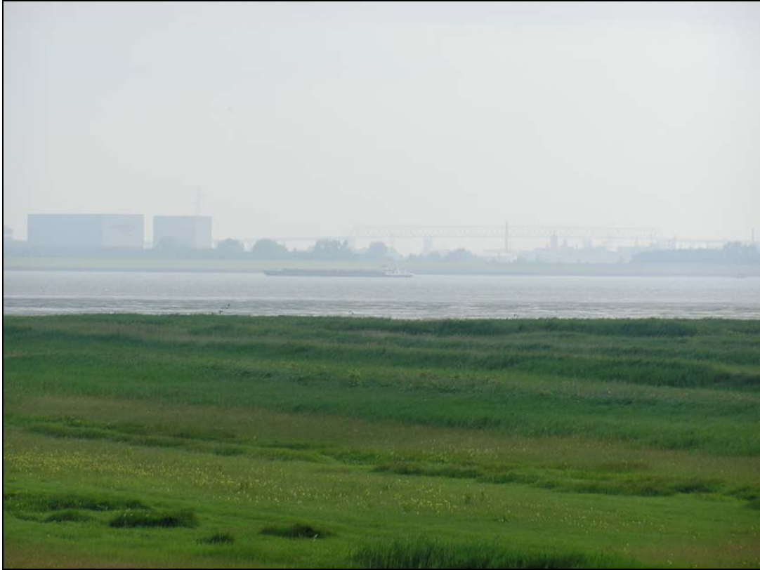
Photo 15: Blick vom Baljer Außendeich: Hallen der F.A. Kruse sowie Hochbrücke der B 5
